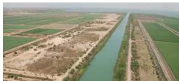
Curage de la Taouey sur 17 km : les travaux ont consisté au curage de 13 000 m<sup>3</sup>, au faucardage de 200 000 m<sup>2</sup> et à la protection de la rive Est en perrés maçonnés sur 30 000 m<sup>2</sup> ;
