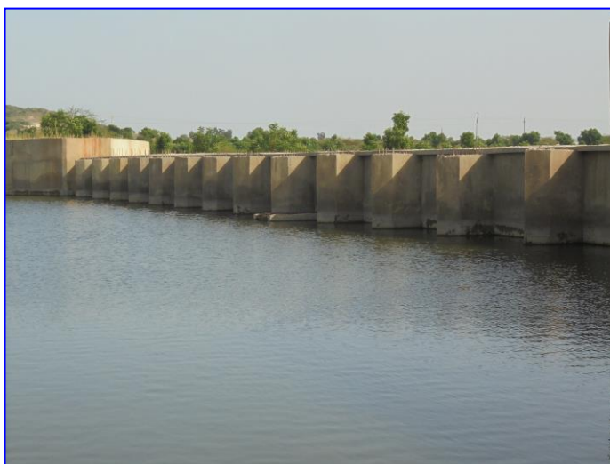
Photo 2 : Ouvrage d'Allou Kagne 1
